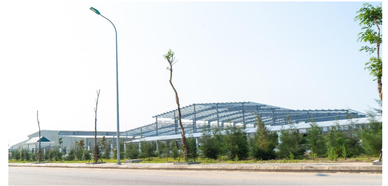
Nhà xưởng giai đoạn 2 của Polyfill sắp hoàn thiện
