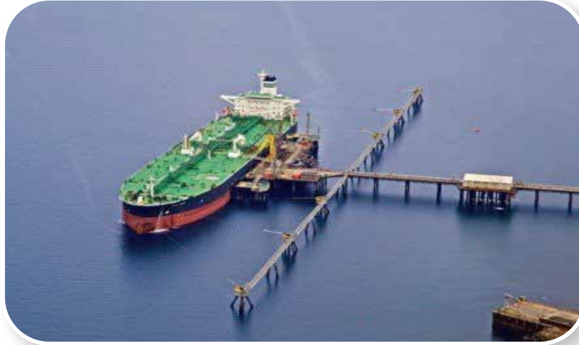
Khởi công xây dựng cầu cảng hàng lỏng, dự kiến đưa vào hoạt động đầu năm 2021
