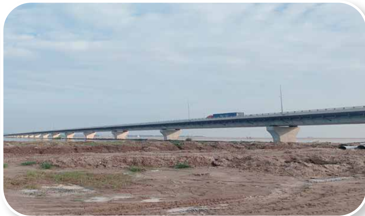
Giai đoạn 2 KCN Nam Đình Vũ hiện đang trong quá trình san lấp 50% mặt bằng, dự kiến tháng 6/2020 có thể bàn giao 210ha đất có hạ tầng cho khách hàng
