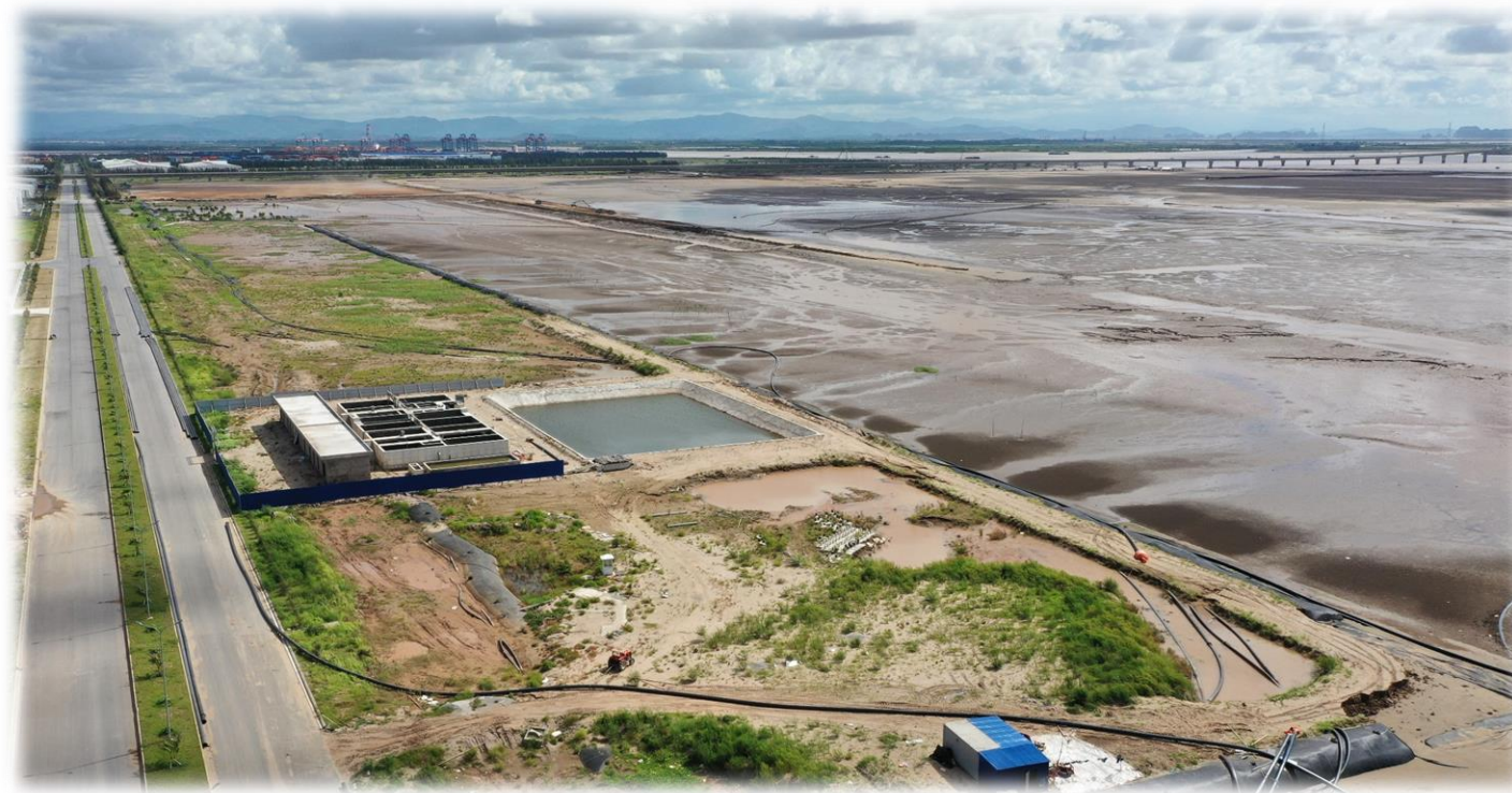
Khu vực đầu mối kĩ thuật mới đang dần được hình thành và 280 ha đất tiếp theo đang được san lấp làm hạ tầng
