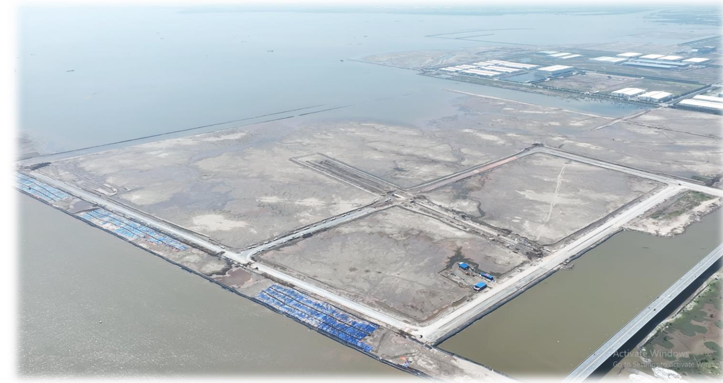
Tuyến đê biển Nam Đình Vũ đang được hình thành
