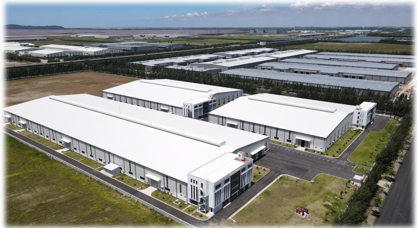
Dự án Tường Viên Nam Đình Vũ mở rộng đã hoàn thiện để đưa vào vận hành
