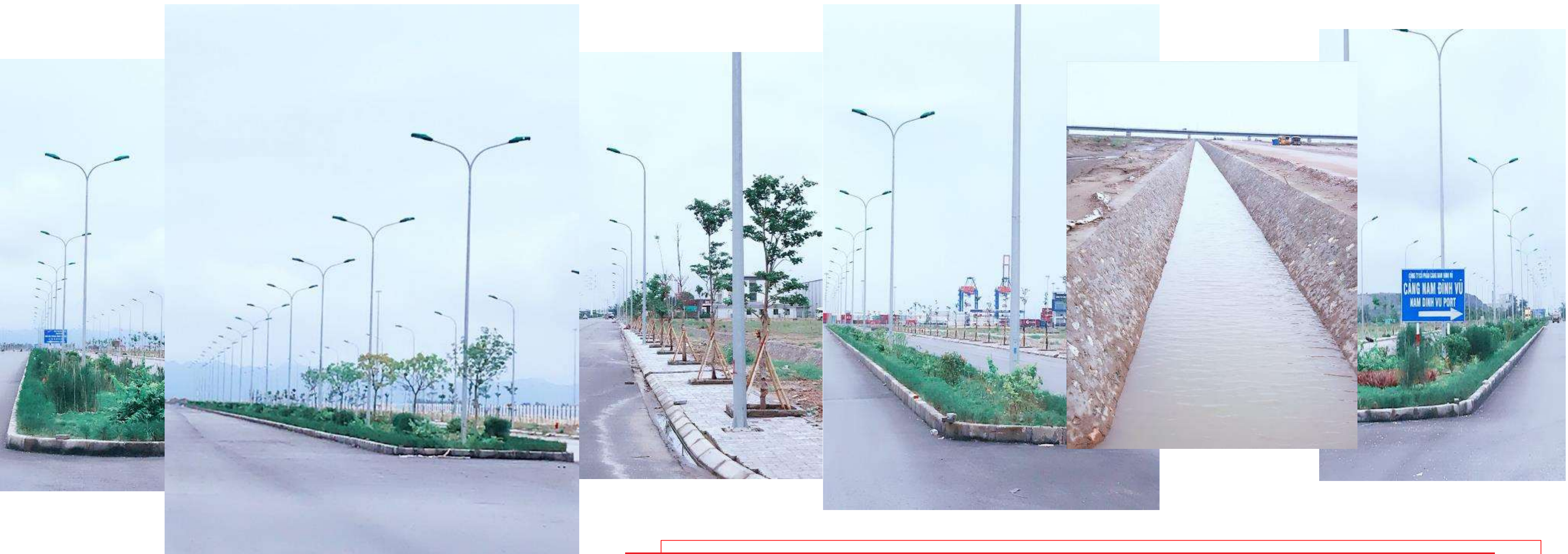
Hệ thống đường nội khu, điện đường , cây xanh, mương thoát nước, các hệ thống kỹ thuật ngầm đã hoàn thành cơ bản 370 ha (giai đoạn 1)
